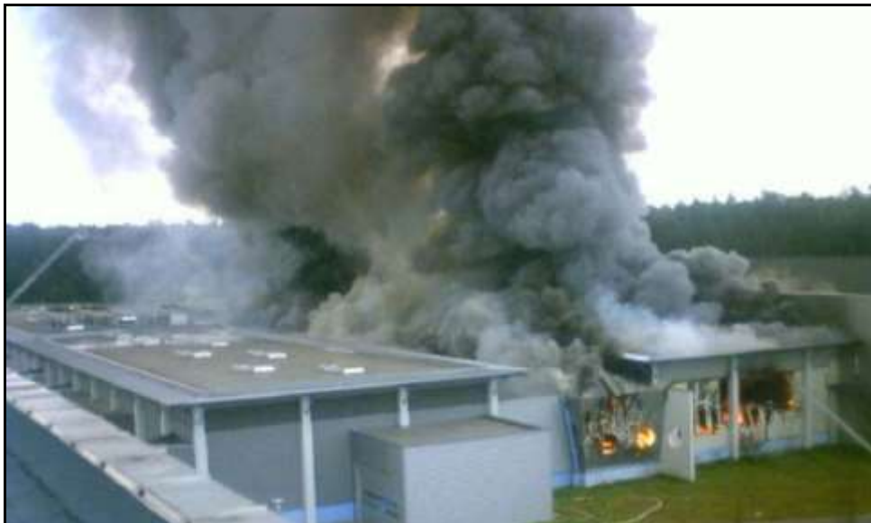
Bild 1 Schadenbeispiel eines Fleischverarbeitungs-Unternehmens
