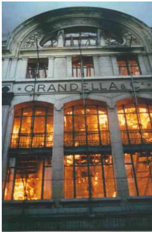
Bild 7 Grandella Gebäude während des Chiado Brandes, Lissabon (P)
