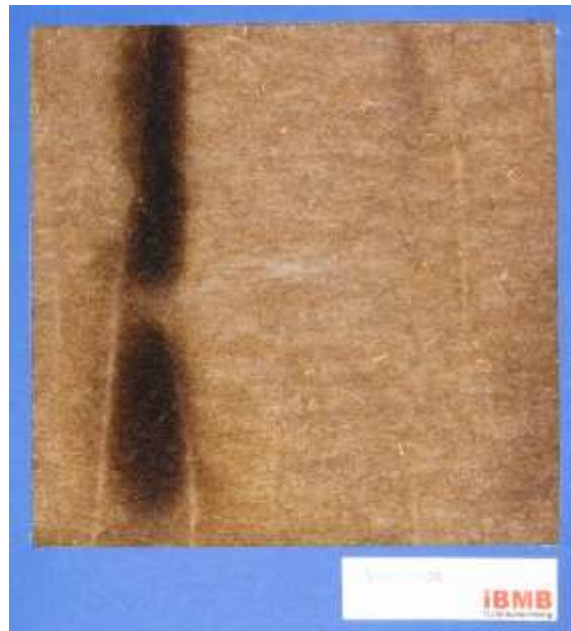
Bild 7 Thermische Zersetzung der Dämmstoffoberfläche im Stoßbereich der Brandschutzbekleidung
