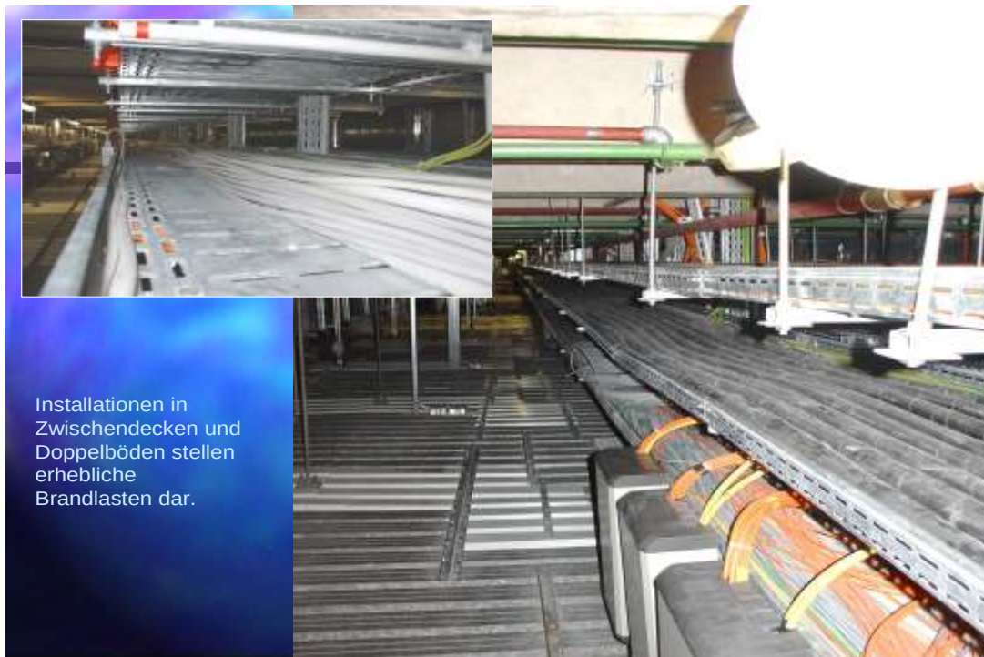
Bild 3 Die Vorschriften für Leitungsanlagen sind kaum noch zu überschauen, insbesondere in Verbindung mit Zulassungen für Zwischendecken.
