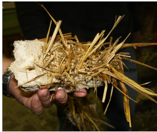
Bild 19 Zustand des Strohs direkt hinter der Putzschicht
