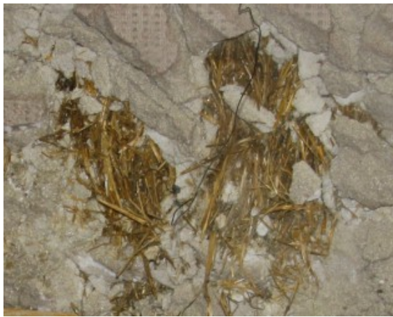
Bild 19 Zustand des Strohs direkt hinter der Putzschicht
