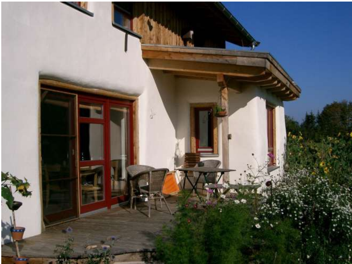
Bild 5 Strohballenhaus mit direkt aufgebrachtem Kalkputz, Bösel [3]
