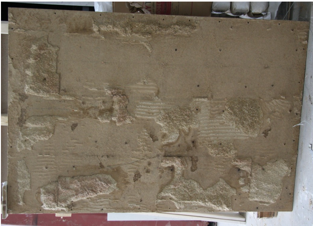
Bild 16 Zustand der Spanplatte hinter der Lehmplatte nach 60-minütiger ETK-Beflammung
