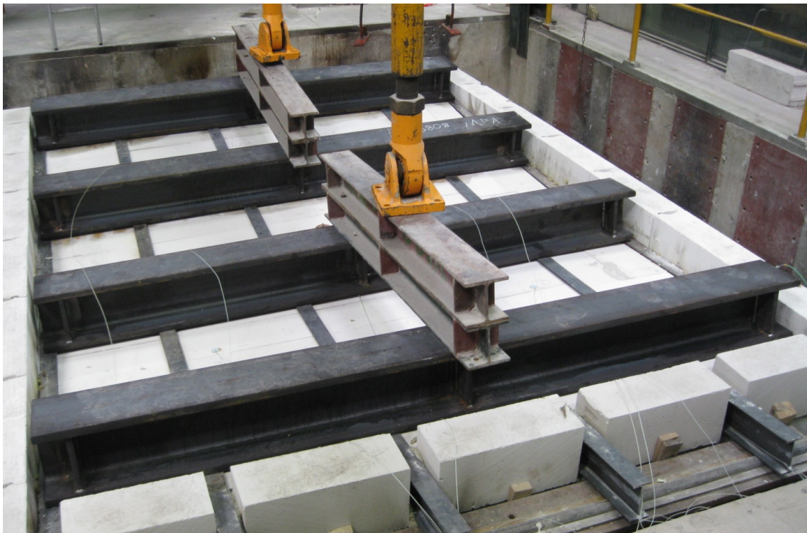
Bild 3: Lasteinleitung bei der Massivdeckenkonstruktion (nach dem Brandversuch)
