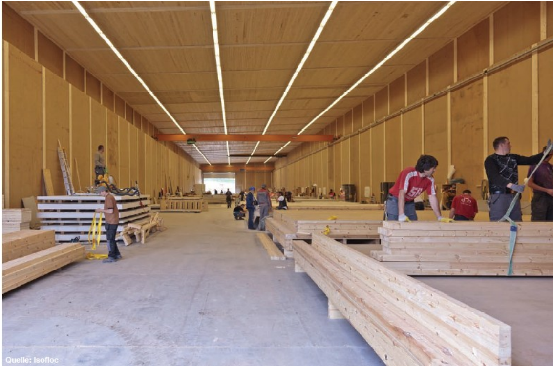
Bild 3 Temporäre Montagehalle (Quelle: Isofloc GmbH, Kassel)
